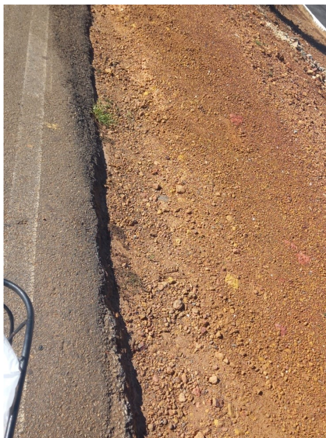
Figura 2: Acostamento de chão batido com inclinação
